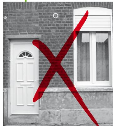
Les portes doivent conserver leur hauteur d'origine ainsi que l'imposte vitrée. L'alignement entre les impostes des portes et des fenêtres doit également être respecté. Les portes préfabriquées ne respectent pas, en général, ces conditions. Avant de remplacer votre porte, assurez-vous qu'il soit vraiment nécessaire de la changer car, dans la plupart des cas, mieux vaut la rénover.
