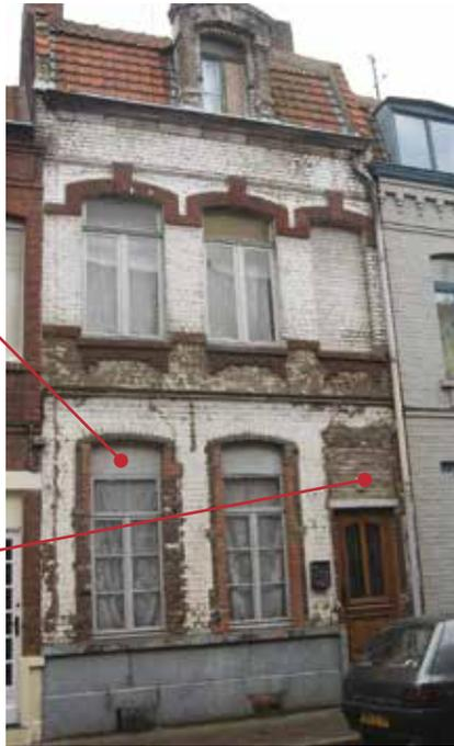
Le compartimentage de fenêtre n'est pas correct : imposte bouchée, dimension de châssis...
