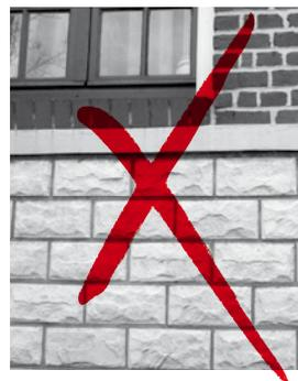
Les matériaux de type pierres de parement ou briquettes ne sont pas conformes. Conservez le soubassement d'origine souvent réalisé en pierres grises, en briques ou encore en ciment peint.
