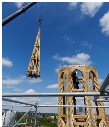
Remplacement de la flèche et du fut du clocher. © L'Œil
