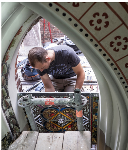
Remplacement des panneaux d'une verrière. © L'Œil
