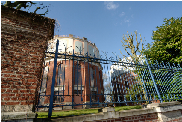
Réservoirs à eau du Huchon © A. Loubry
