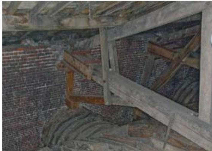
1. Jambe de force en partie moisée, blochet et potelet remplacé, about d'entrait et d'arbalétrier dégradés, Ferme I
