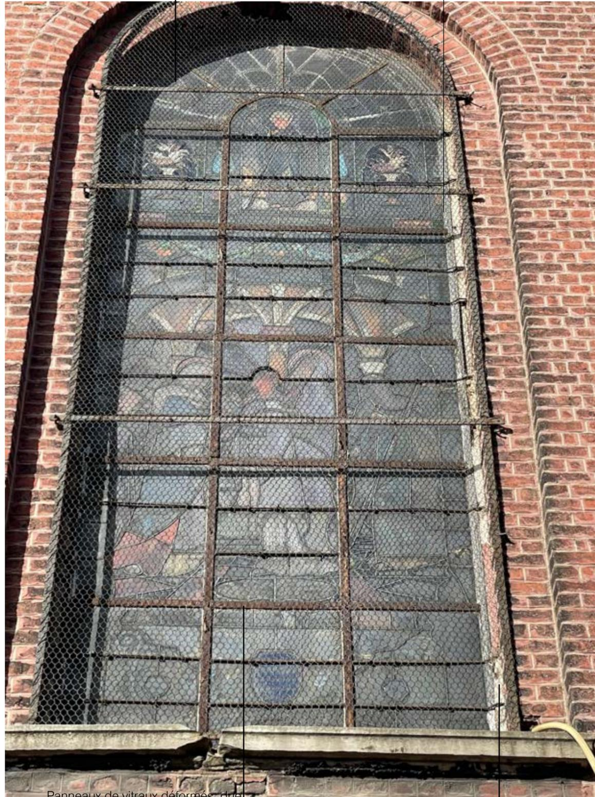
Panneaux de vitraux déformés, due à l'absence de possibilité de dilatation et à l'oxydation de la ferronnerie
