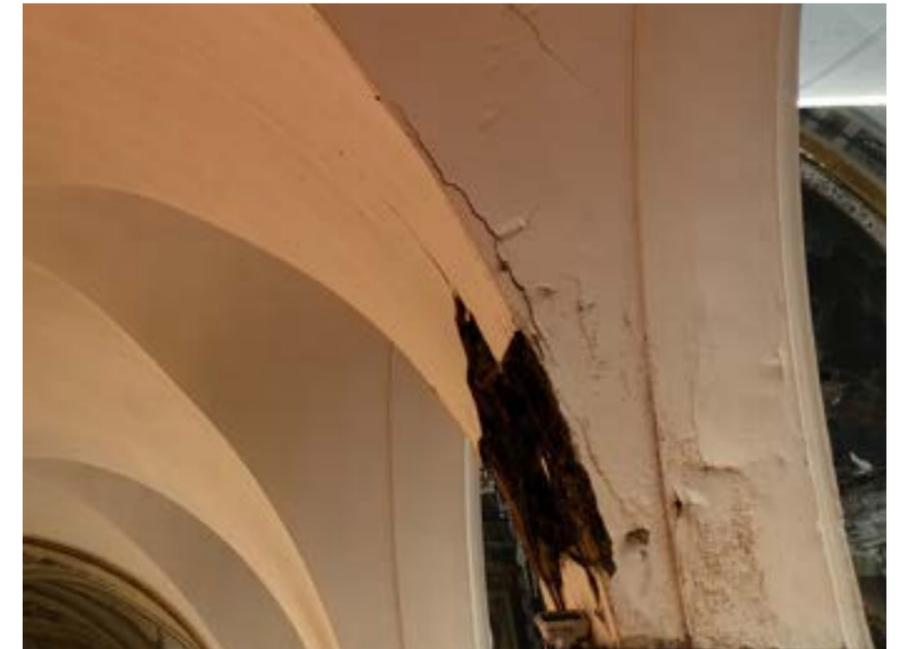
2. Un écoulement d'eau le long de la maçonnerie du Bas-côté Sud a entraîné la chute du revêtement et la dégradation des bois supportant la voûte
