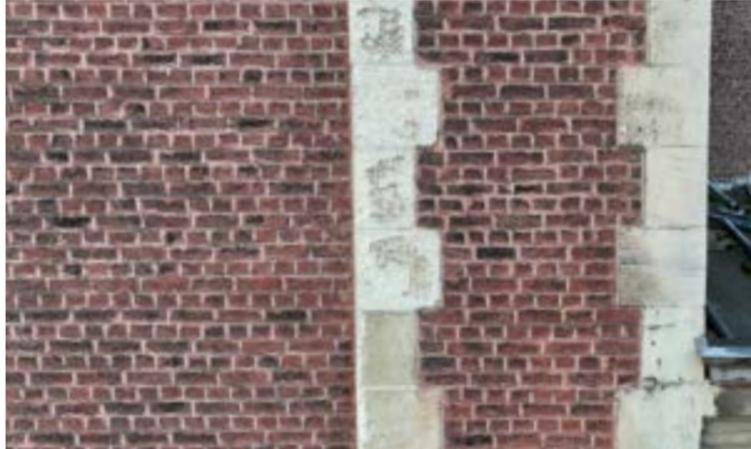
Maçonnerie en brique, joints de différentes natures : ciment, chaux, teintes variables
