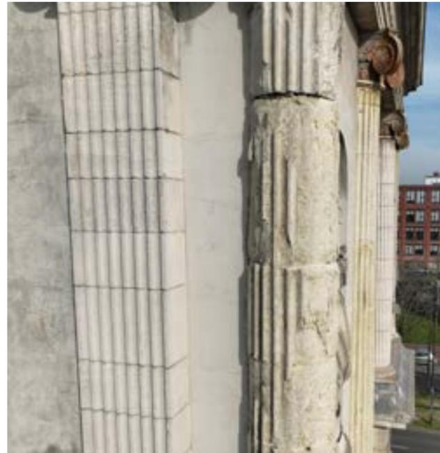
Cannelure des colonne dégradée, chapiteaux en fontes corrodés en surface et peinture écaillée
