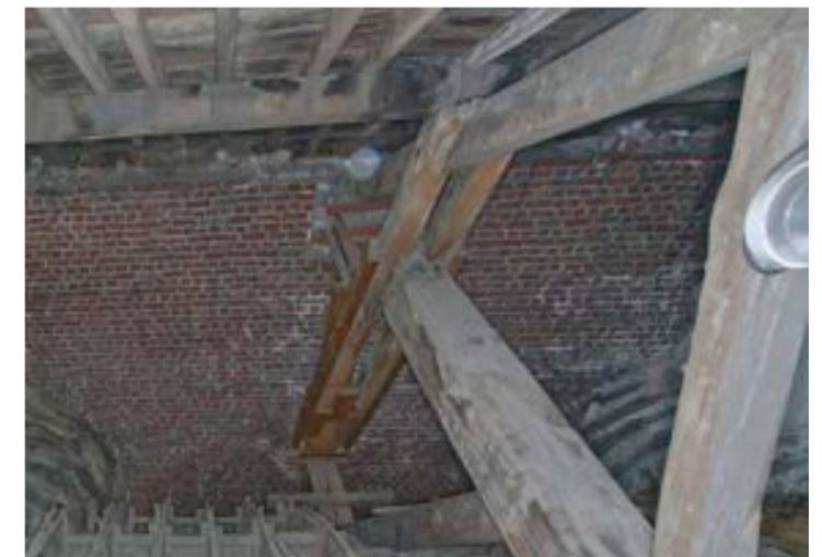
5. About d'entrait et d'arbalétrier dégradés, potelet dégradé Blochet dégradé, Ferme IX
