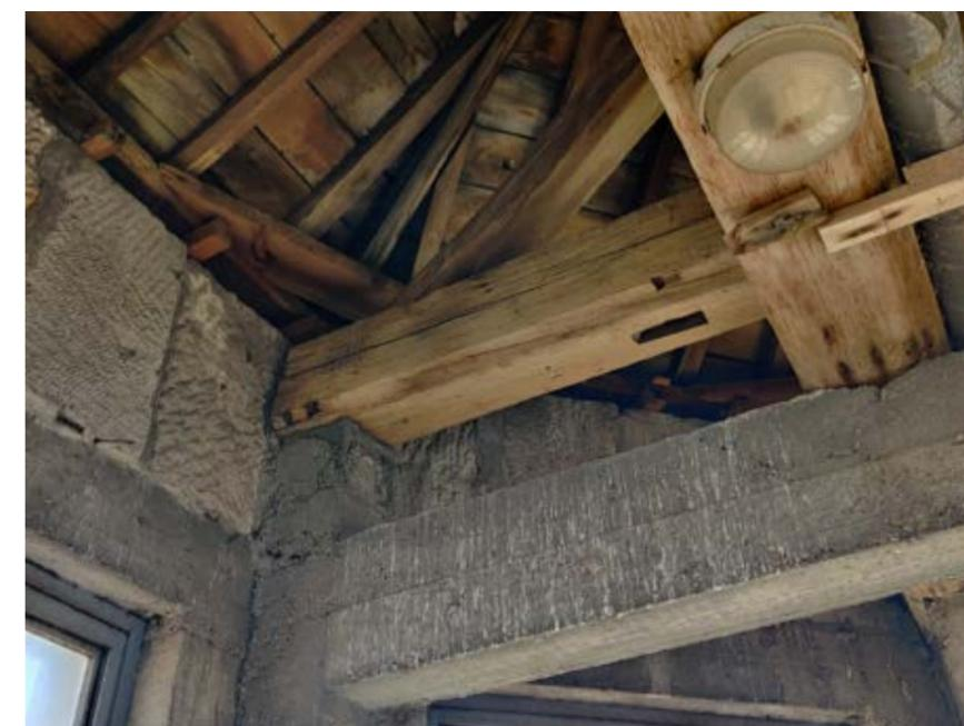
6. L'enrayure de la poivrière octogonale du lanterneau est en bon état, les chevrons et le lambris ont quant à eux subi des dégradations dues à l'infiltration d'eau depuis la toiture zinc.
