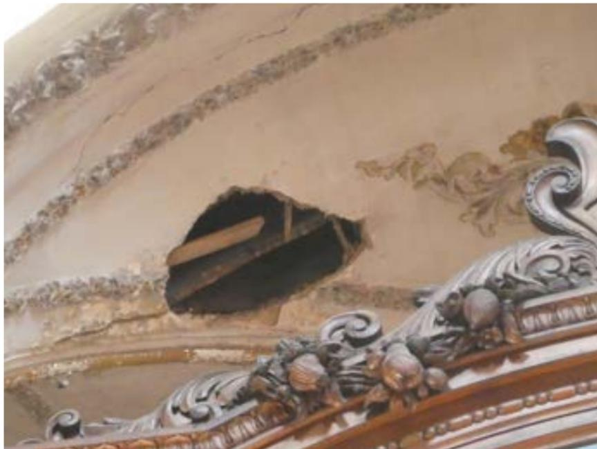
3. La présence d'humidité dans le Bas-côté Nord induit l'effondrement de certaines parties du plafond des voûtes.
