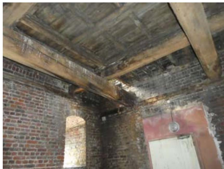
1. L'angle Sud-Ouest de la tour présente une infiltration d'eau entraînant des dégradations importantes de la charpente plus particulièrement ici des affaissements et une décomposition avancée des parties en appuis sur la maçonnerie.
