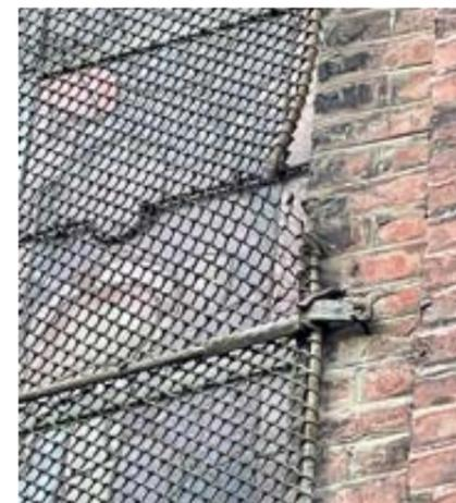
Descellement des fixations des grilles de protection
