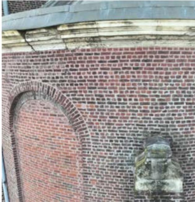
Détachement ponctuel de la pierre, due aux infiltrations d'eau, pulvérisation, dégradation biologique
