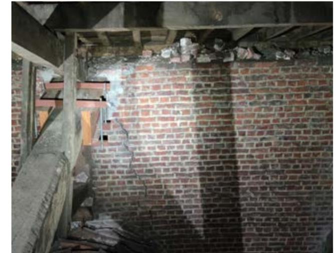
2. Fissure importante à côté de la ferme V
