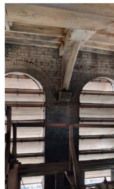
5. La charpente du beffroi de cloche est dans un meilleur état global, elle est cependant très dégradée au niveau de l'écoulement d'eau qui est présent au Sud-Ouest de la tour.
