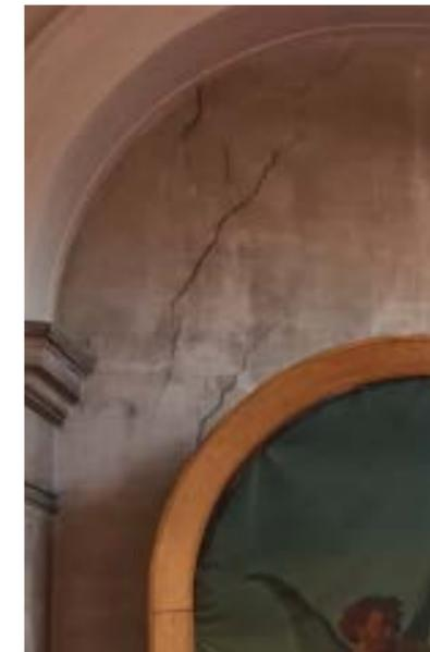
9. Fissuration du stucco sur les colonnes
