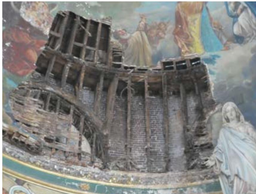
4. La défaillance de la toiture couvrant le cul de four a entraîné l'effondrement d'une part importante du plafond et de son décor principalement au niveau des baies murées. L'humidité dégrade également la structure bois de la voûte en cul de four.
