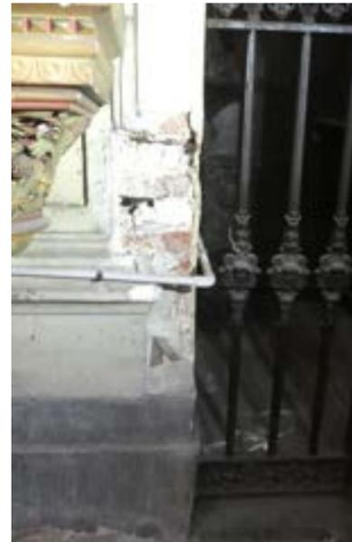
1. Dégradation du stucco due à l'humidité
