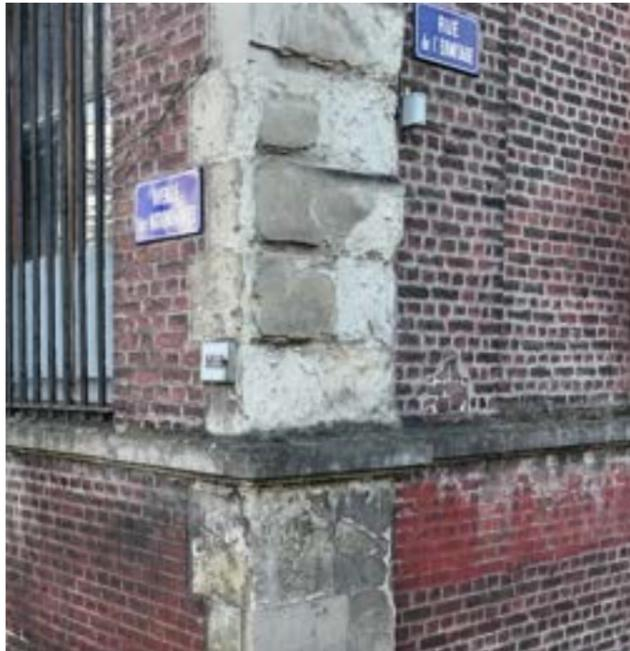
Le chaînage en pierre est altéré (exfoliation), présence de graphites en parties basse, et encrassement important des appuis et de la brique
