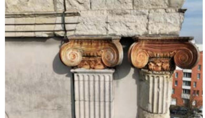
Colonne et pilastre en pierre d'Euville avec chapiteau en fonte de style ionique
