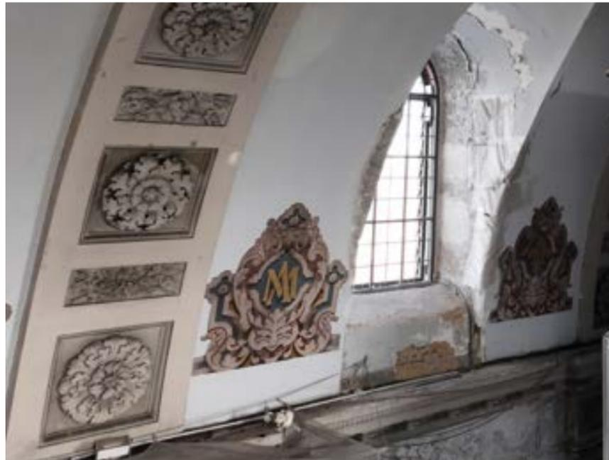
1. Les voûtures présentent des traces d'humidité principalement au niveau des jouées et du contact avec la charpente. Des reprises du revêtement plâtre peu esthétique sont également constatés. Infiltrations et développement de champignons dans la structure bois et l'ossature de la corniche en staff
