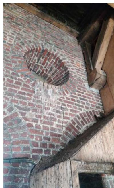
3. La maçonnerie du mur Est présente une fissure en dessous de l'oculus.
