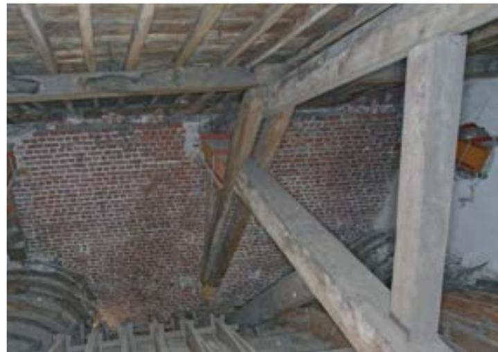
3. Jambe de force en partie moisée, blochet et potelet remplacé About d'entrait et d'arbalétrier dégradés, Ferme VI
