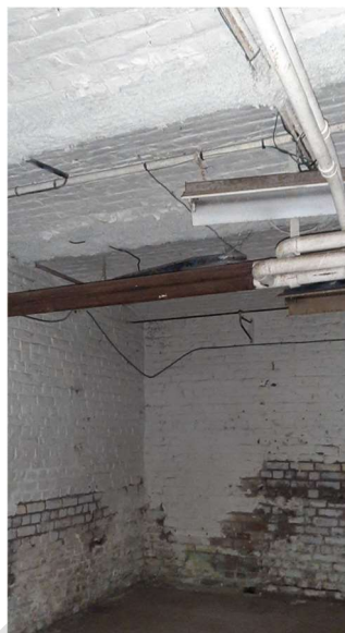
Figure 106 - Voutains brique en sous sol
