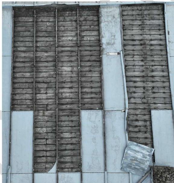
Figure 43 - Disparition de la couverture zinc
