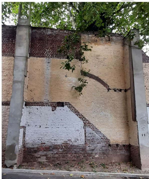
Figure 121 - Renforts conservés sur mur mitoyen Vilogia
