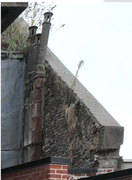
Figure 113 - Conduits cheminées sur pointe pignon
