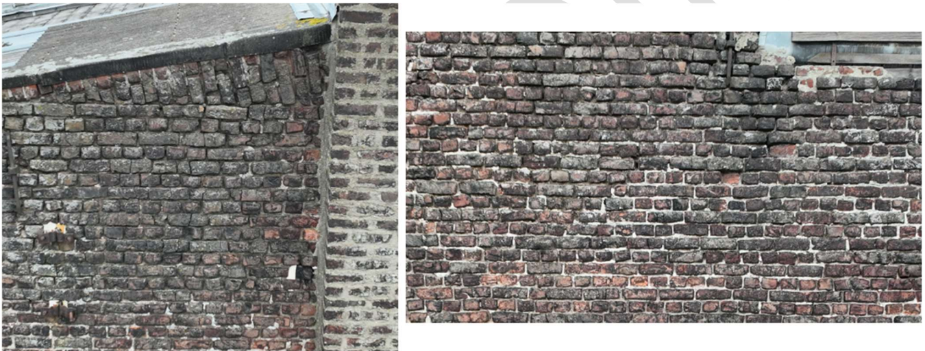
Figure 67 - Exemples de l'état des joints de maçonnerie
