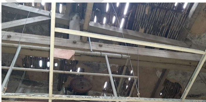
Figure 91 - Charpente exposée aux intempéries
