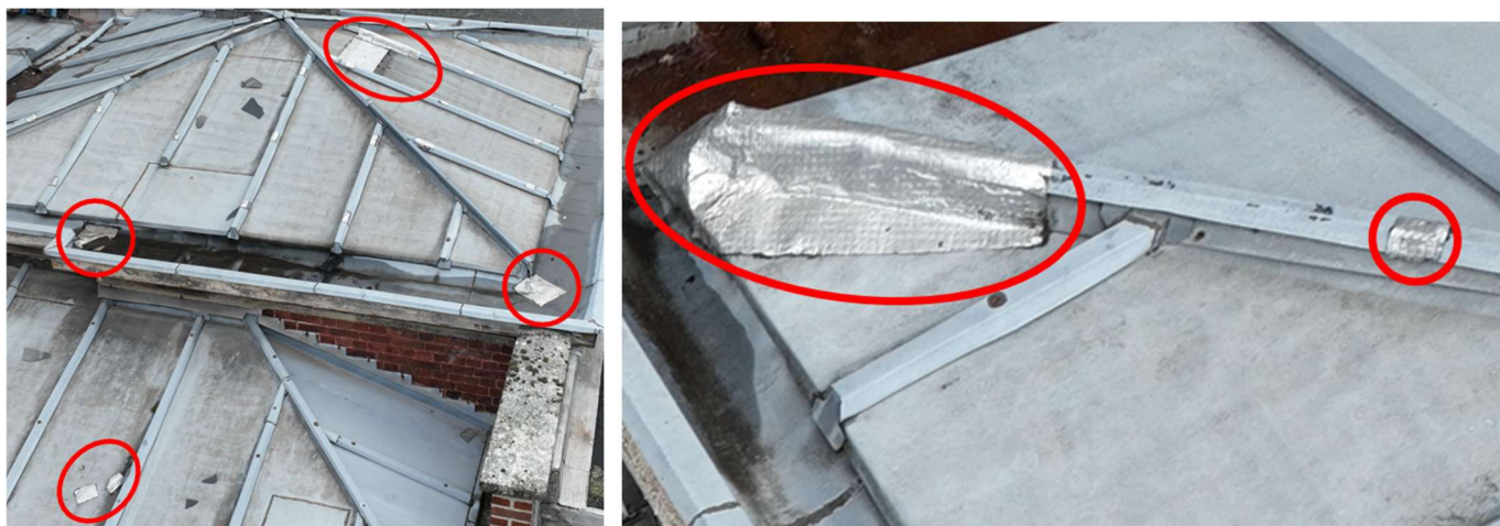
Figure 55 - Réparations ponctuelles de la couverture zinc
