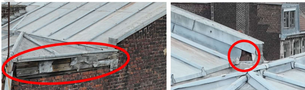
Figure 31 - Défaut étanchéité couvre mur (côté façade Est)
