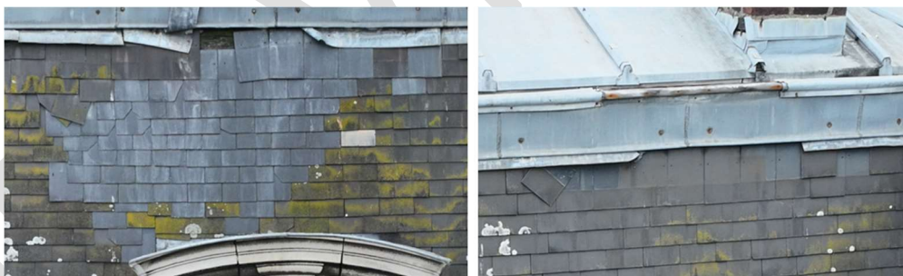
Figure 34 - Décrochage d'ardoises en cours
