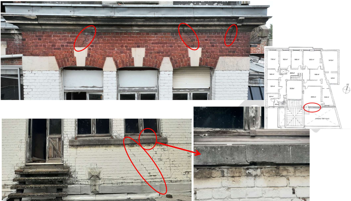
Figure 78 - Fissures sur façade Sud
