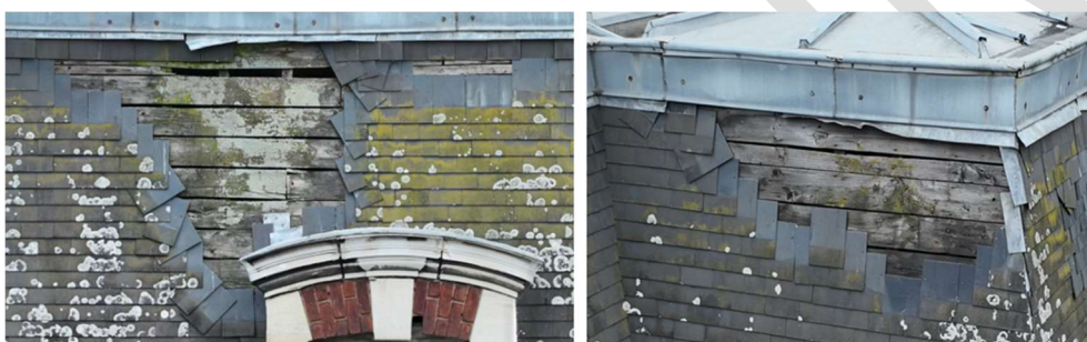
Figure 33 - Absence d'ardoise sur brisis en façade Sud
