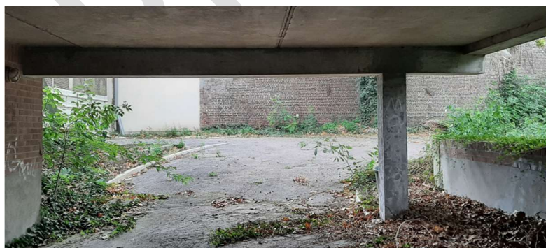
Figure 86 - Sous sol extension 1988 en ossature béton
