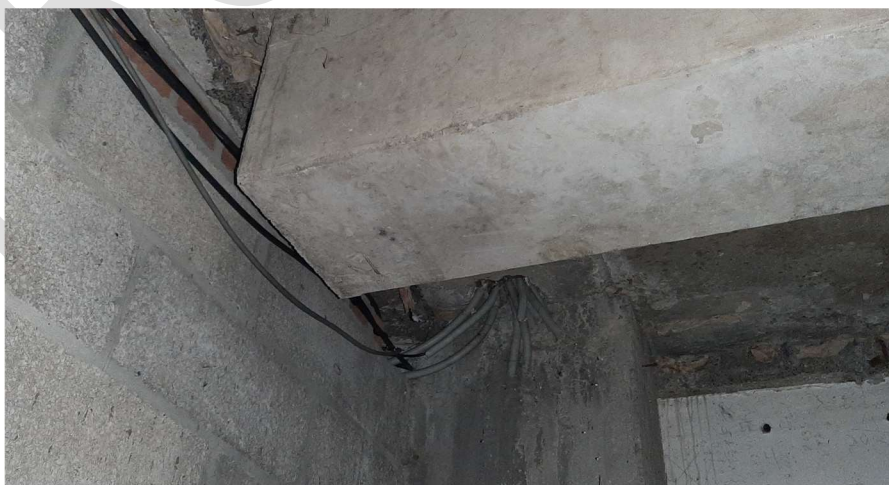
Figure 108 - Poutre en console de l'extension de 1988 (désolidarisation par rapport à l'extension de 1966)
