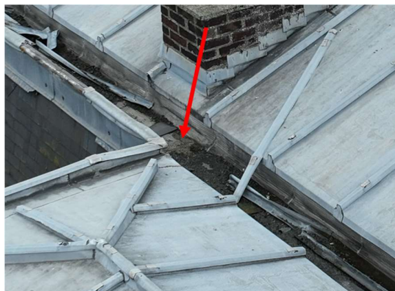
Figure 36 - Paxalu vieillissant en remplacement du chéneau
