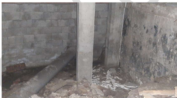
Figure 107 - Poteaux et fondations de l'extension de 1988 sur vide sanitaire
