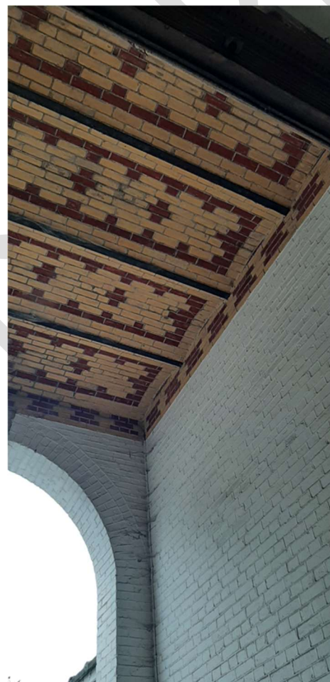
Figure 71 - Plafond décoratif en briques vernissées
