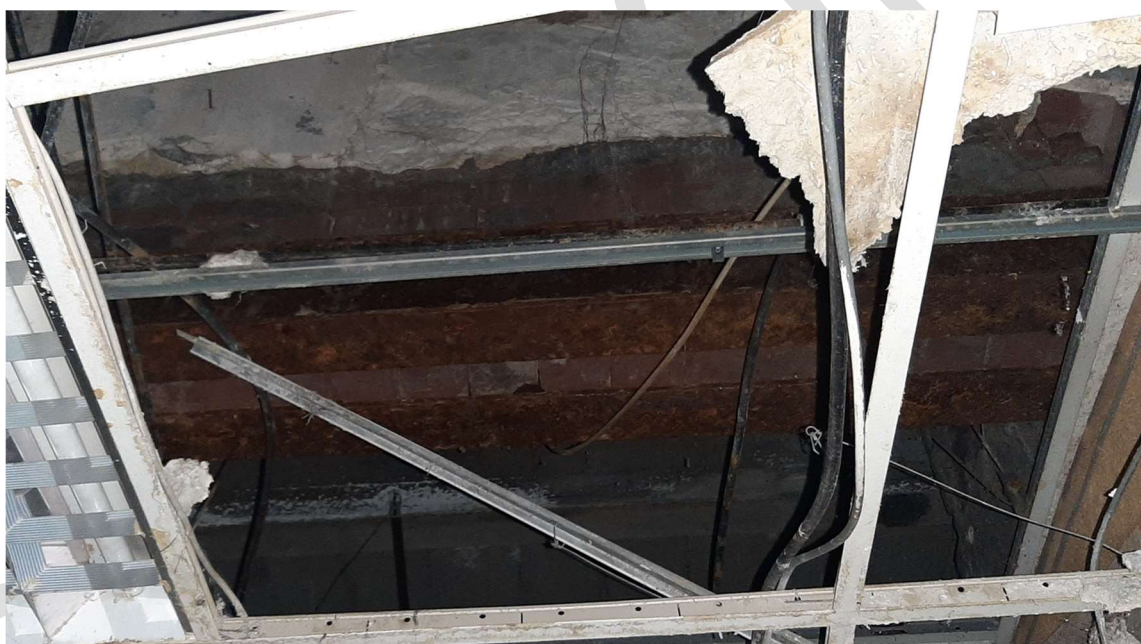
Figure 105 - Renforcement sous façade Sud pour extension de 1966
