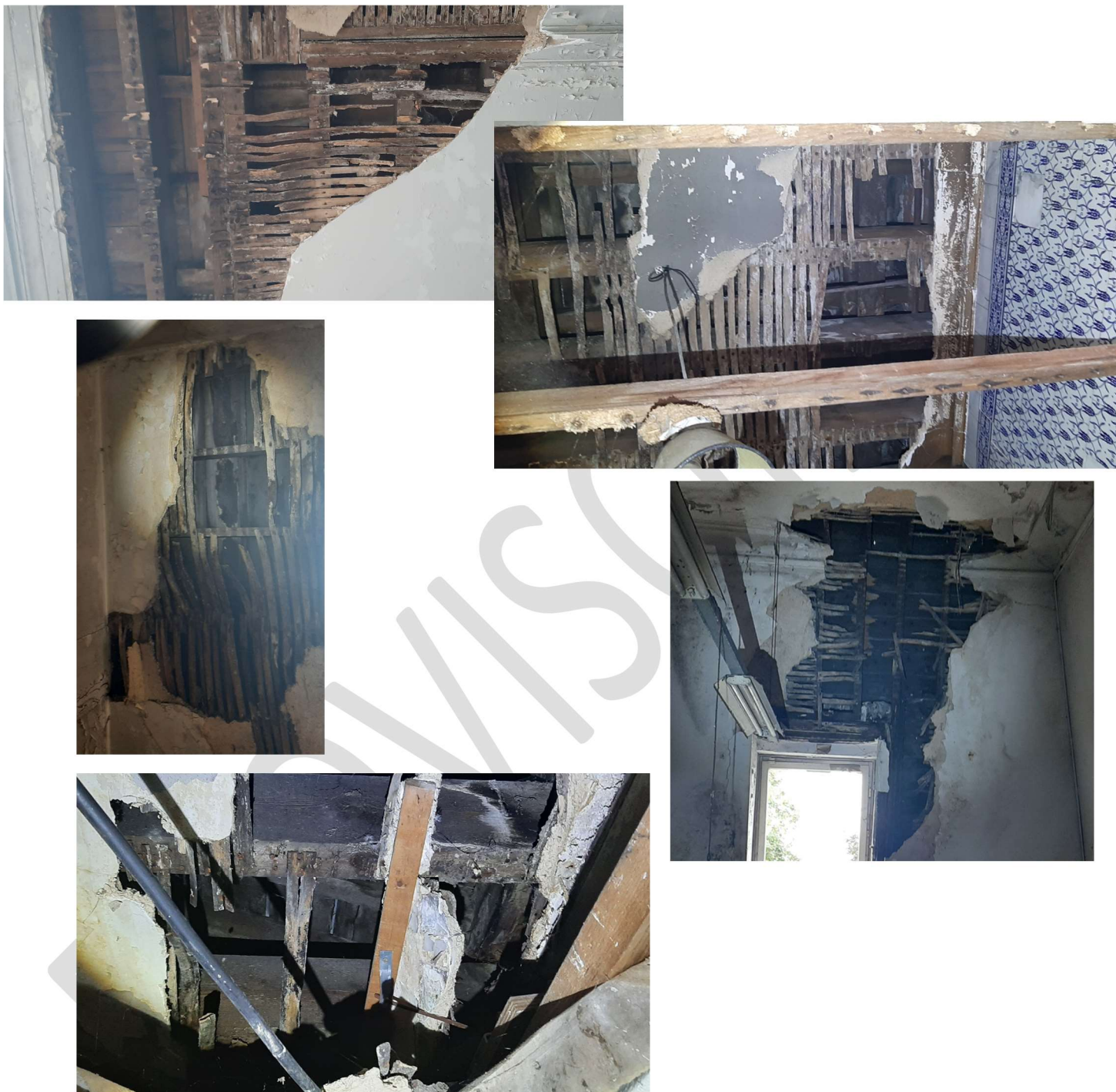
Figure 96 - Chute des plafonds type Bacula
