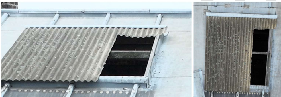
Figure 25 - Couverture absente sur toiture Sud
