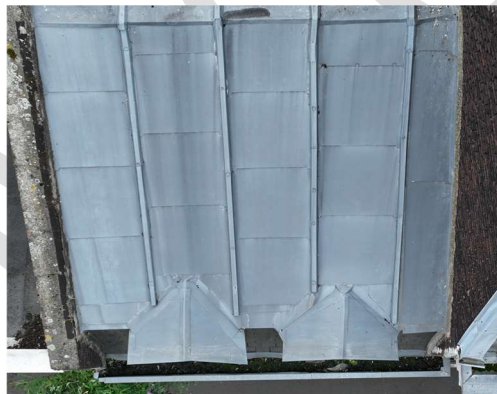
Figure 49 - Terrasson en couverture zinc sur tasseaux (façade Nord du n°72)
