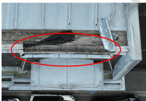
Figure 46 - Couvertine absente sur ligne de brisis de la façade Nord et Paxalu vieillissant dans chéneau
