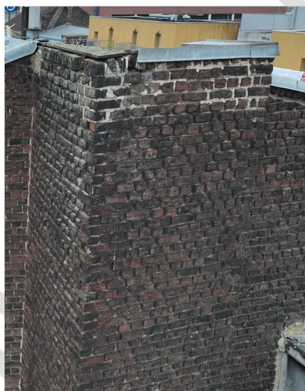
Figure 73 - Joints de maçonnerie dégradés
