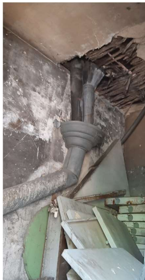
Figure 90 - Descente d'eau intérieure
