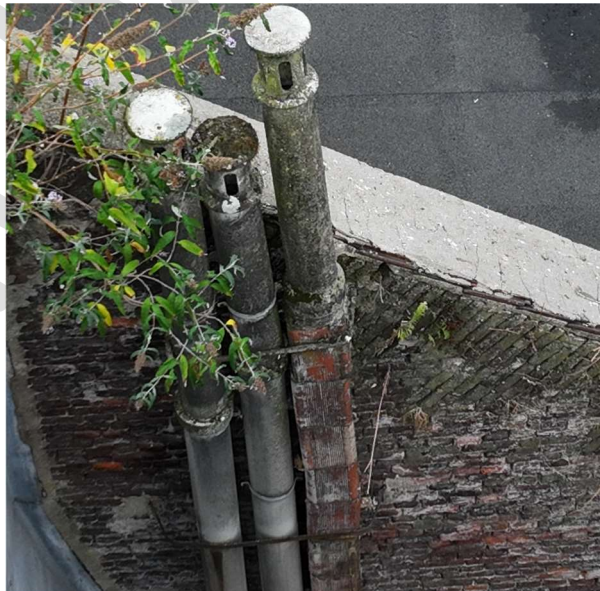
Figure 113 - Conduits cheminées sur pointe pignon
