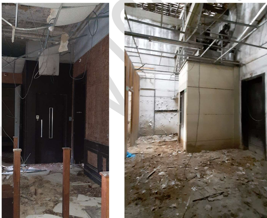
Figure 98 - Chutes de dalles de faux-plafonds
