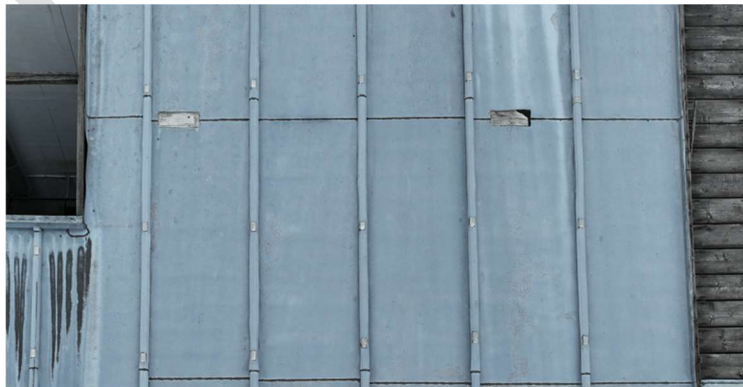
Figure 44 - Réparations sur bacs zinc
