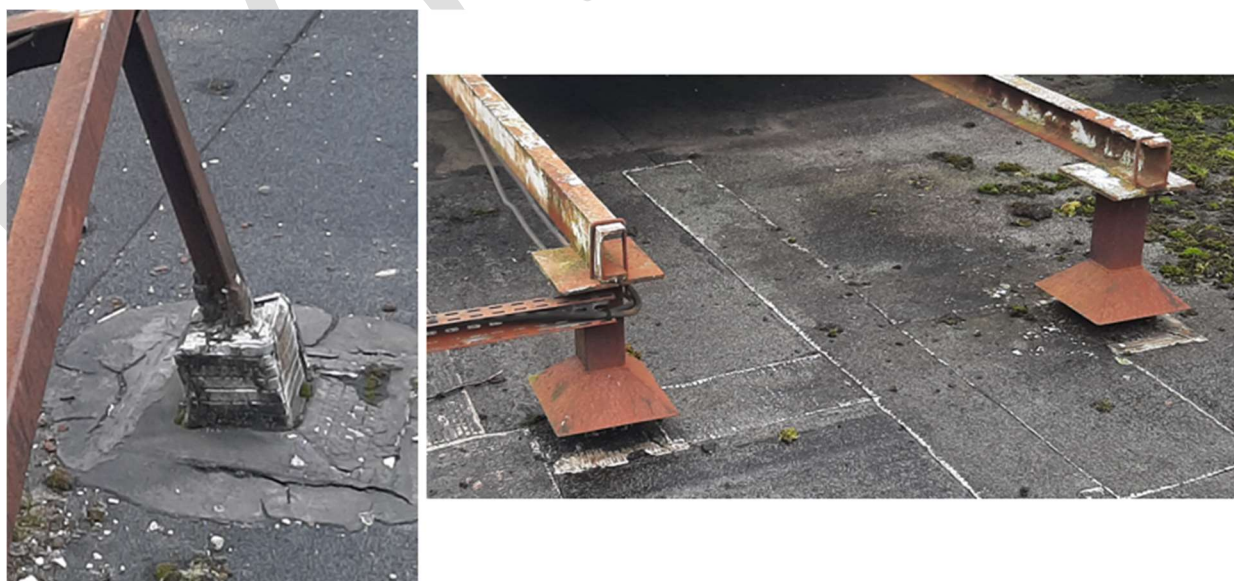
Figure 61 - Etanchéité à revoir aux points singuliers
