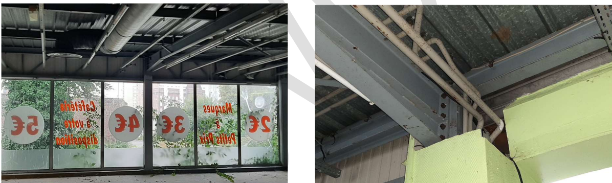
Figure 102 - Extension 1988 - Ossature métallique et bacs aciers
