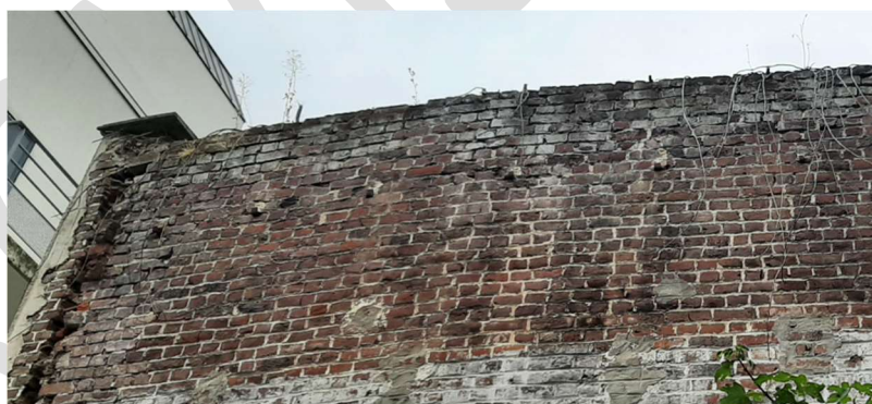
Figure 123 - état de la maçonnerie et de la liaison avec mur perpendiculaire
