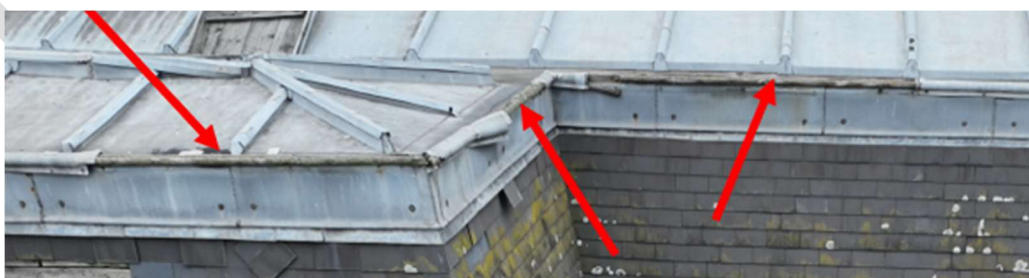
Figure 35 - Défaut étanchéité sur chéneau
