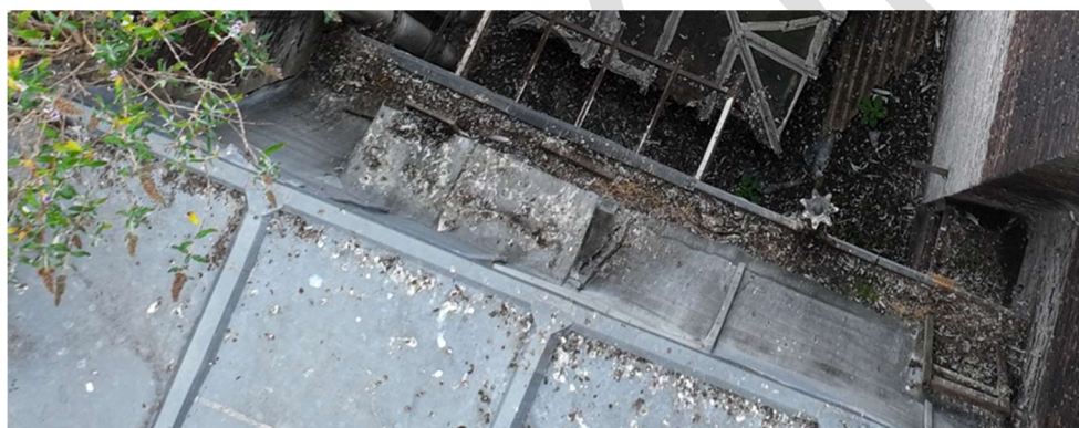
Figure 52 - Chéneau colmaté par fientes
