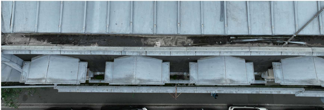
Figure 48 - Evacuation des EP défailante
