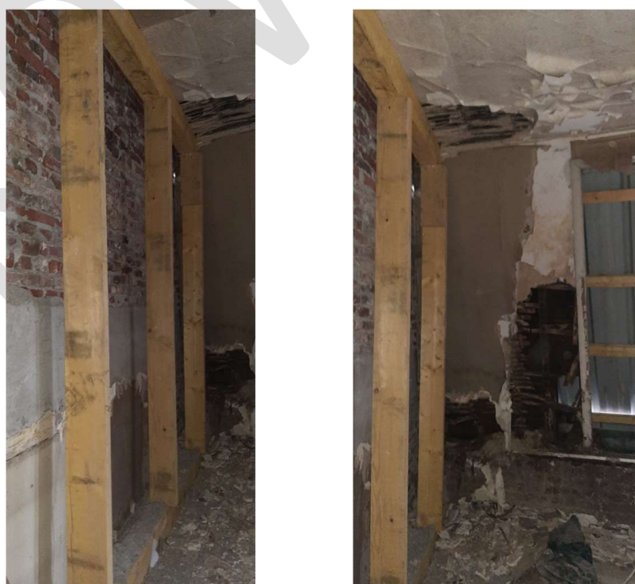
Figure 115 - Reprise de la charpente existante
