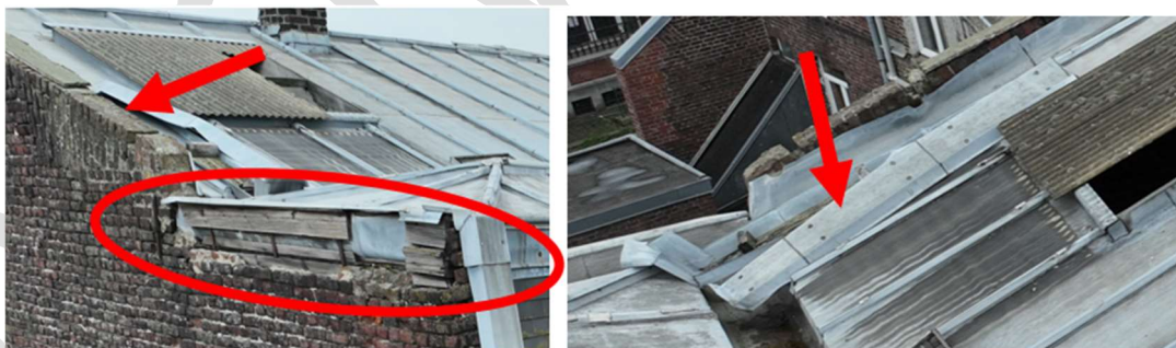
Figure 30 - Couvre-murs non fixé (côté façade Ouest)
