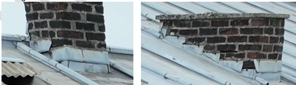
Figure 27 - Défaut étanchéité souches cheminées
