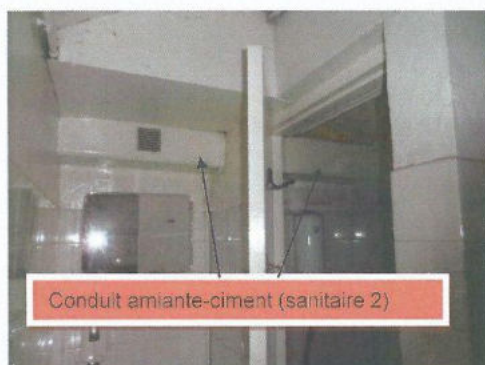
Conduits amiante-ciment (passage galerie)
